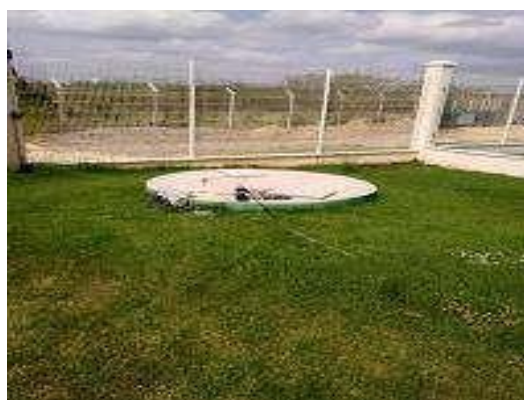
Figura 1. Imagens dos dispositivos de tratamento de esgoto sanitário na estação.
