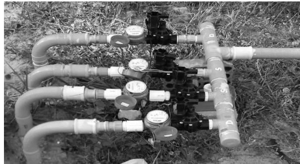
**Figura 6.** Válvulas solenoides e hidrômetros para controle e medição da vazão
